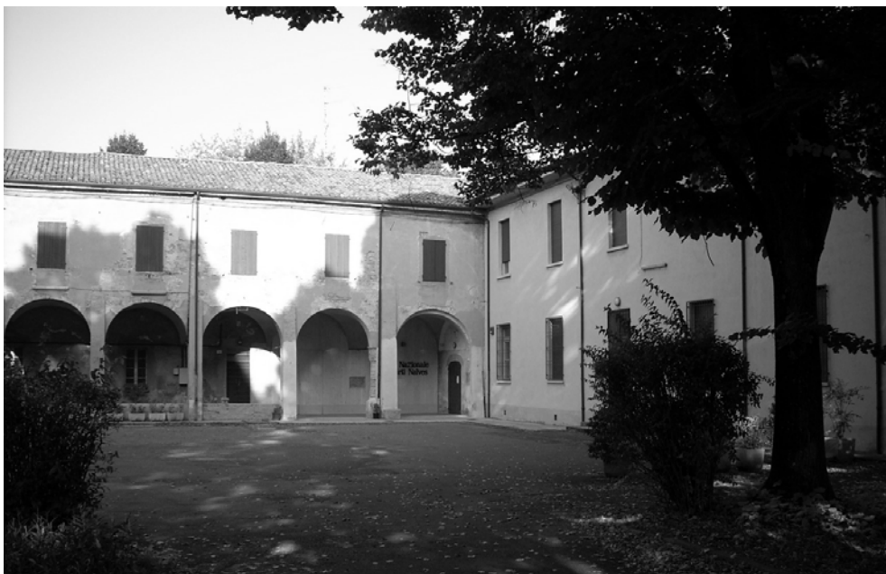
Fig. 18 - Cortile interno del convento, a destra l'edificio in giallo costruito nel 1948 (foto 2007).
