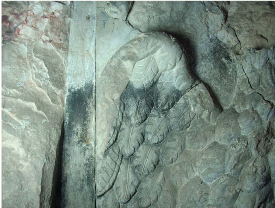
Fig. 14 - Monumento necrologio Luigi Gonzaga: particolare dell'aquila destra con i segni d'abrasione. (foto 2007)
